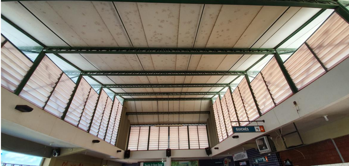
Figura 1 – Cobertura e Sheds que deverão receber trabalho de limpeza.
